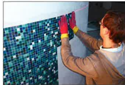
Mosaikarbeiten mit Laser-Unterstützung in der Rupertus Therme in Bad Reichenhall.
